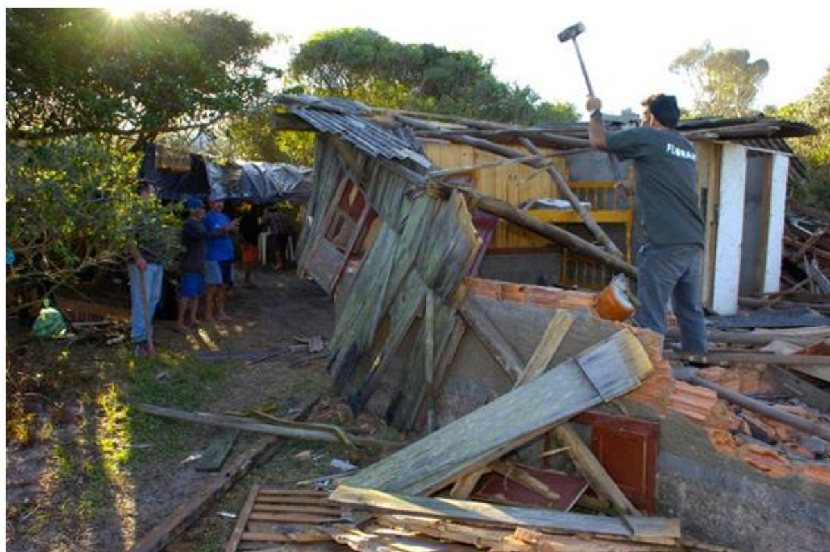
Figura 4: Demolição de ranchos na Praia de Naufragados
